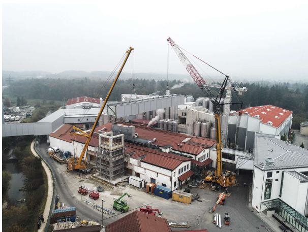
Bild 1: Bereits im Herbst 2020 wurde die Versorgungsbrücke eingesetzt. Erst im Anschluss wurde die ehemalige Verladehalle abgerissen, um Platz für das Gebäude der neuen Produktion IV Platz zu machen.
